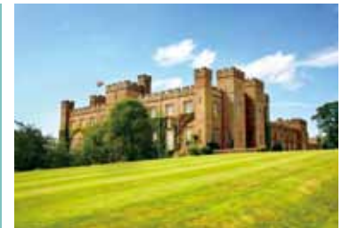
のどかな丘の上に建つスカーン宮殿の全景。
