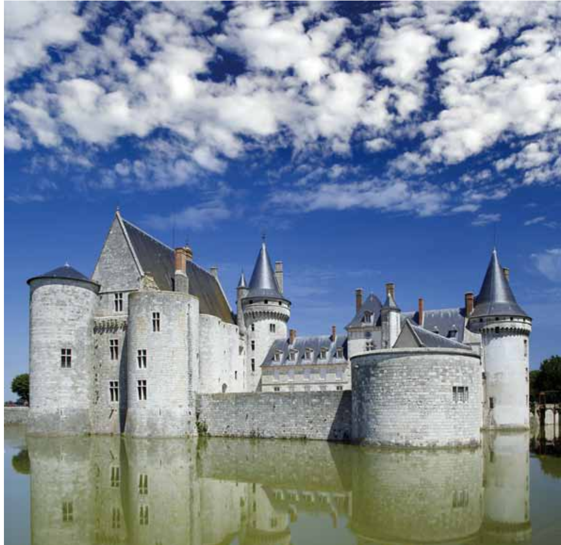
シュリー・シュル・ロワール城全景。堀に直接土台が築かれている様子がよくわかる。
